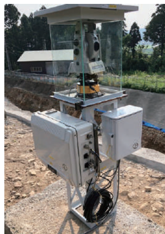
コンクリート基礎
